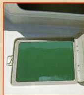
プロベラ点検ハッチ
